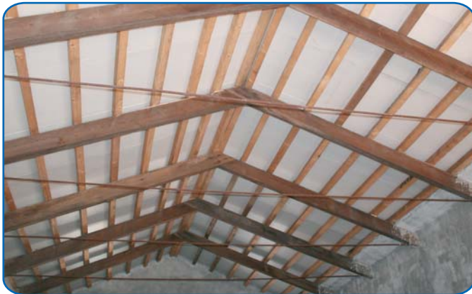
Exemple d'application de la Plaque TEGOLA ISOLIFE avec rive universelle et ligne de faitage horizontal.
